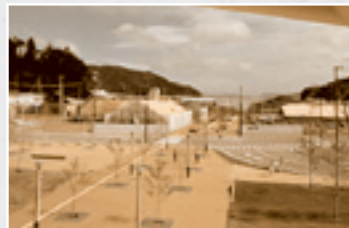
▲商店街の建設工事が進む駅前プロムナード。湾左手には女川魚市場や水産加工団地が並ぶ。
