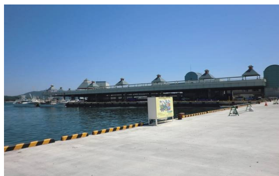
▲ことし5月に岸壁の復旧工事が終わった気仙沼魚市場。2013年の水揚量は震災前の66%にとどまる。
