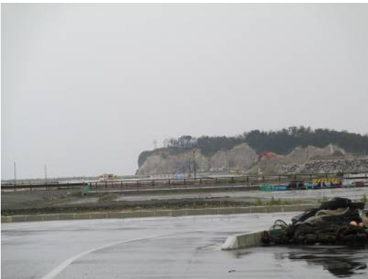
津波で破壊された海岸線 (松川浦海岸)
