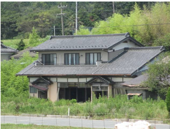
津波で1階部分が破壊されたままの家 (南相馬市)
