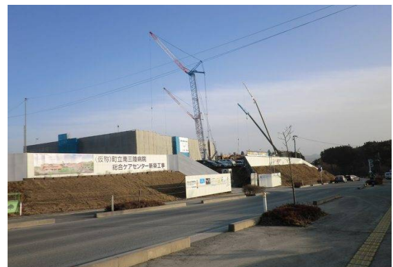
▲写真2: 2015 年秋の開院予定を目指し、工事が進む「(仮称)町立南三陸病院・総合ケアセンター」
