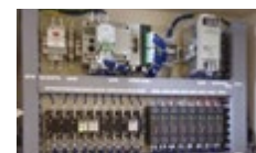
BEMS(ハーツはるえ) 店舗のショーケースを自動管理するエネルギー管理システムBEMS。
