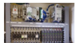
BEMS(ハーツはるえ) 店舗のショーケースを自動管理するエネルギー管理システムBEMS。
