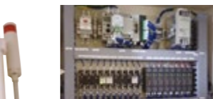
BEMS(ハーツはるえ) 店舗のショーケースを自動管理するエネルギー管理システムBEMS。
