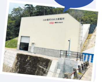
COOP黒河川水力発電所
